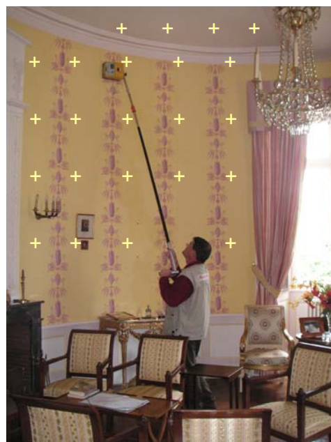
Mur, façade, plafond
