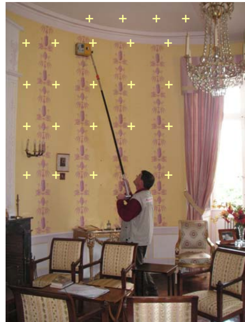
Mur, façade, plafond
